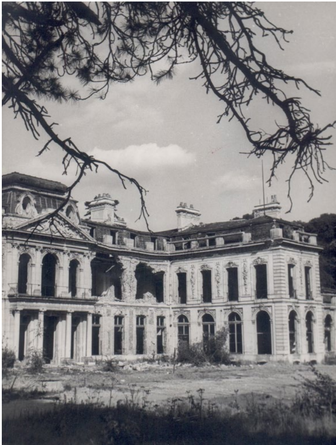
1 er février 1956. Sur le fronton triangulaire, côté sud, les personnages servant de support au cadran solaire sont là pour exprimer l'idée que «le temps fait passer l'Amour». Archives municipales, photographie remise par les familles Jame et Thoprieux.
